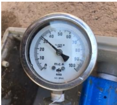
Rua Joaquim M. Castelhana, 395
