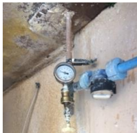
Rua Antônio Ribaldo, 31
